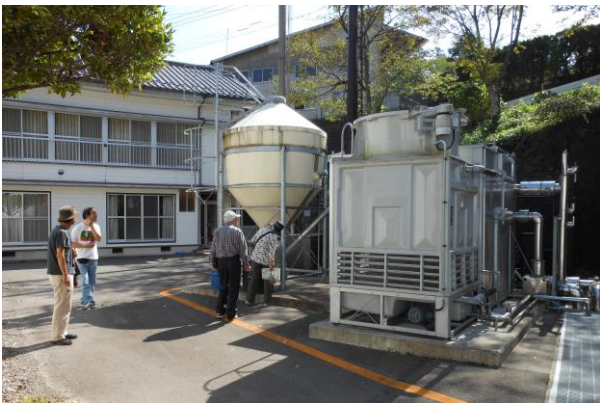
↑ 歴史資料館の冷暖房の熱源に木質ペレット発電装置
