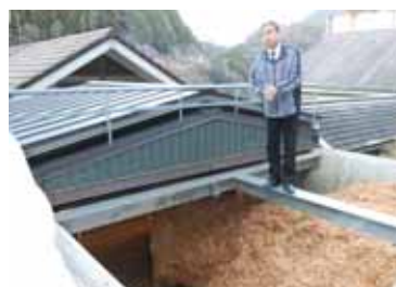
月の湯温泉は冷泉のため、間伐材のバイオガスで沸かし、室内暖房にも活用
