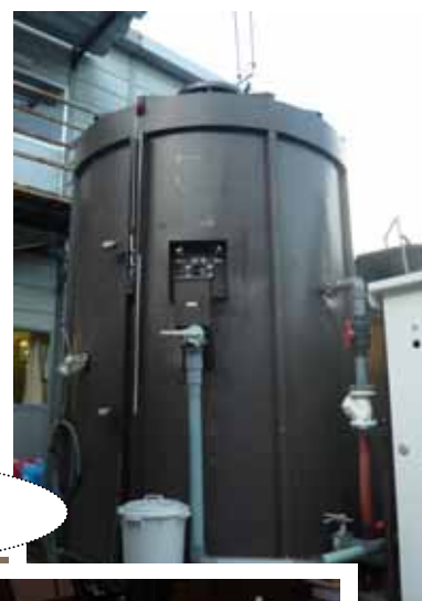
榎原の棚田と水車 現役で動く バイオメタン 室内ではコンロの熱源実験中
